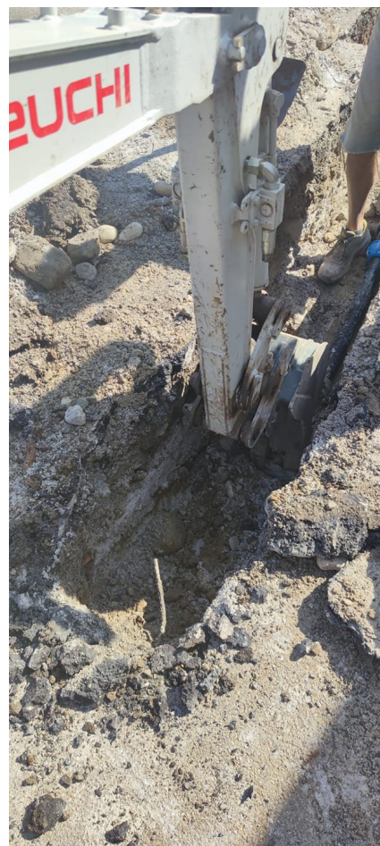
Manutenzione della rete idrica
