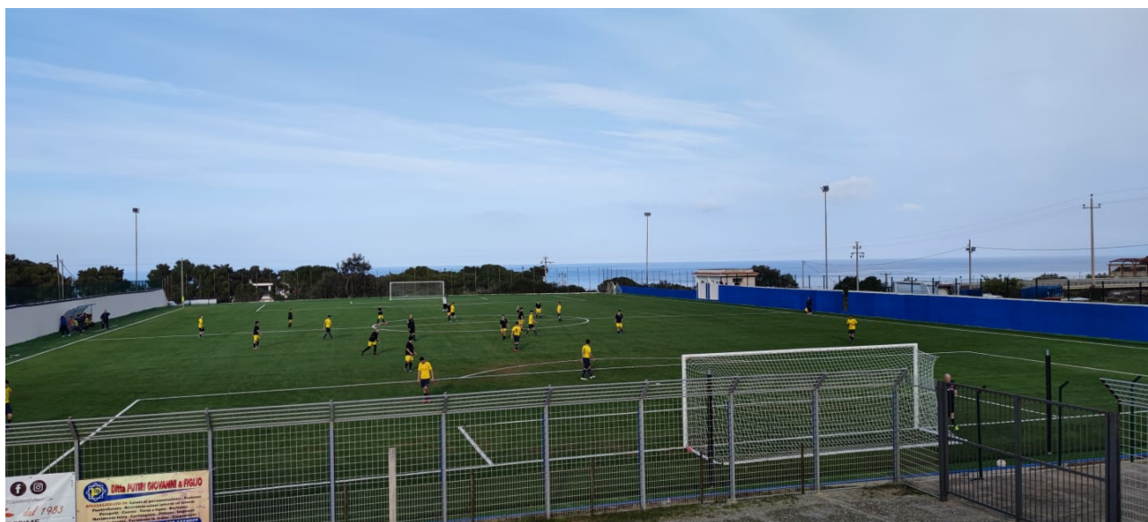
Il campo sportivo San Giuliano dopo i lavori
